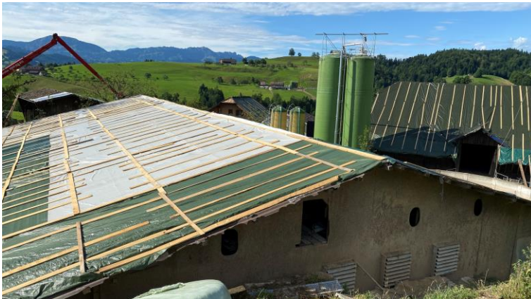
Bild 1: Ein Notdach verhindert weitere Schäden (zvg Gebäudeversicherung Luzern)
