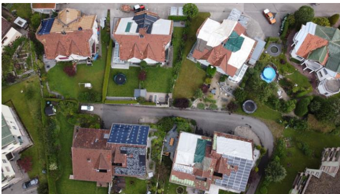
Bild 2: Zerstörte Dächer und Photovoltaikanlagen (zvg Feuerwehrinspektorat GVL)
