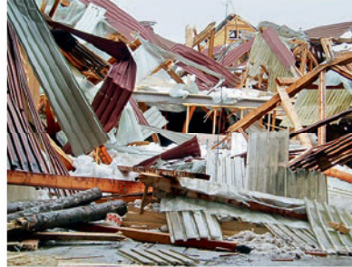
Beispiele von Hallendacheinstürzen mit Holz- und mit Stahlträgern.
